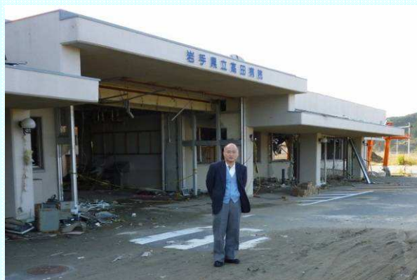
①壊滅した岩手県立高田病院前で
